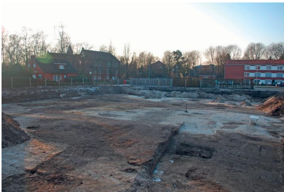
Abb. 1: Leer Blick über die Grabungsfläche von Nordosten. Im Vordergrund ist der östliche, große Graben Befund 40 als dunkle Verfärbung zu erkennen, im Hintergrund parallel dazu verlaufend Graben Befund 13. (Foto: K. Hüser)
