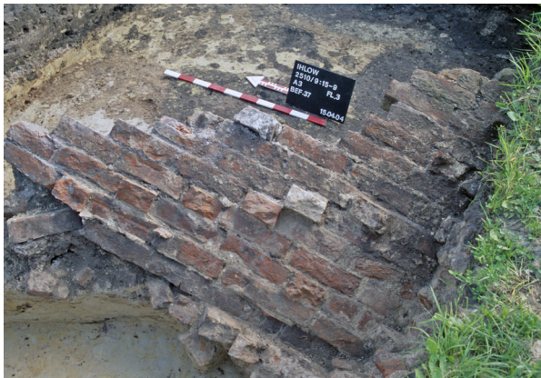
Abb. 1: Ludwigsdorf. Umgestürzte Mauer des klösterlichen Gebäudes: Außenschale nach Entfernung des Gusskerns. (Foto: M. Brüggler)
