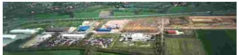
Blick aus luftiger Höhe über die Großbaustelle in Nortmoor (Foto H. Unkel).
