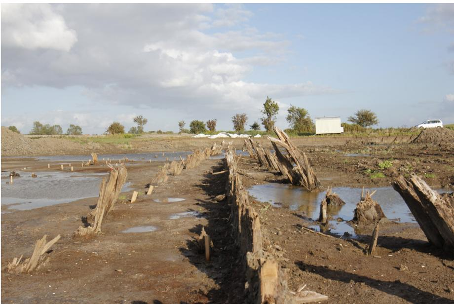
*Abb. 1: Widdelswehr. Die durch Baggerarbeiten freigelegte Holzkonstruktion des Stackdeiches, Blick vom Nordwestende nach Süden. (Foto: S. Krabath, Dresden)*
