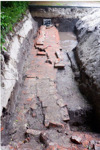
Abb. 1: Weener. Detail der östlichen Fundamente der Synagoge in Weener. Im Vordergrund durch Hitze zerrüttete Backsteine. In der Mitte durch den Einsturz der Mauern verschobene Fundamentlagen. (Foto: A. Prussat)
