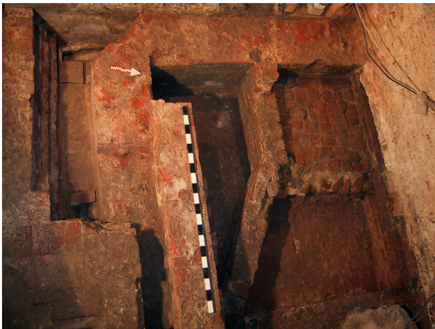
Abb. 1: Aurich. Reste der Vorgängerbebauung unter dem Anbau des Marstalls, z. T. von jüngeren Einbauten überdeckt: Im Süden ein abgetreptes jüngeres Fundament (nachträglich in den Anbau eingesetzt), nördlich davon eine Wasserleitung, z. T. mit fehlenden Abdeckplatten, und die Fundamente des Vorgängerbaus mit zwei verschiedenen Pflasterungsebenen. Unter dem Maßstab verläuft eine weitere jüngere Mauer (ebenfalls nachträglich in den Anbau eingesetzt). (Foto: K. Niederhöfer)
