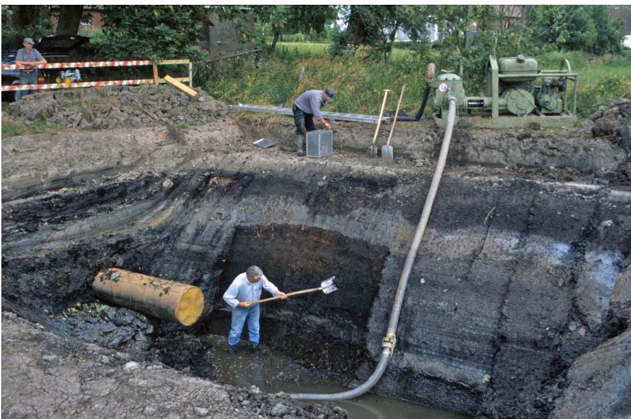
Abb. 1: Bunderhee. Vorarbeiten zur Dokumentation eines Profils mit Torf- und Kleischichten im Verlauf der Pipelinetrasse. (Foto: E. Riemann)
