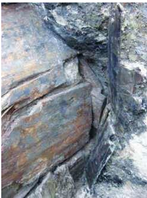
Abb. 3 Detail der Zisterne mit erhaltener äußerer Verschalung (Foto: S. Busch-Hellwig).
