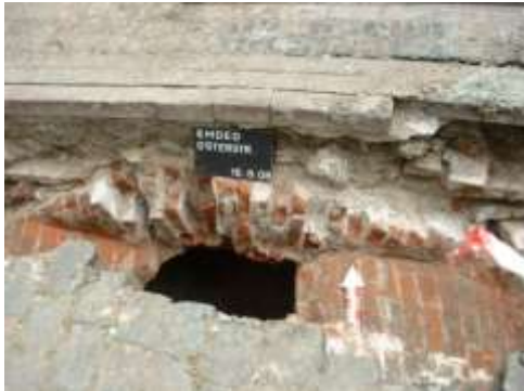
Direkt unter der Straßendecke wurde das Gewölbe der „Osterbrücke“ freigelegt, die die Stadtteile Groß- und Mittelfaldern miteinander verband.
