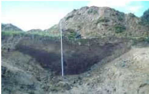
Burggraben im Profilschnitt (Foto: E. Riemann).
