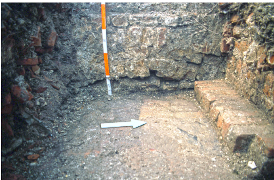
Abb. 1: Grimersum. Innenseite der Außenbauer mit Entlastungsbogen der ältesten Bauphase sowie unterste Stufe einer wandparallelen Treppe (rechts). Der Maßstab ist in Schritte von jeweils 20 cm eingeteilt. (Foto: J. Saathoff)
