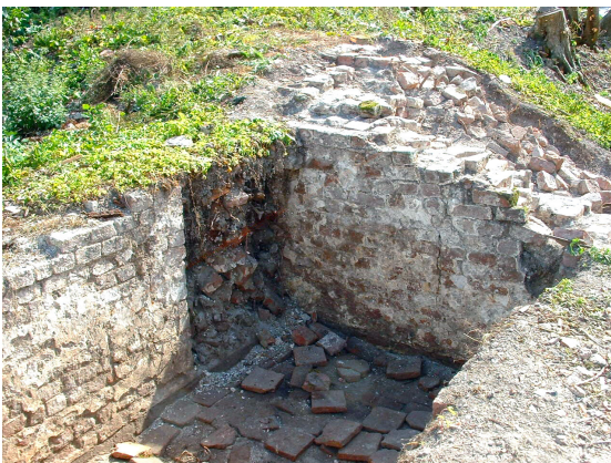
Abb. 2: Grimersum. Altes und neues Mauerwerk der Außenmauer (links) mit Versturzung im Burggraben (rechts). (Foto: J. Saathoff)
