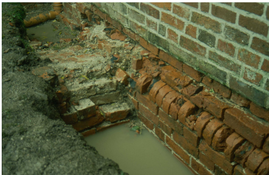
Abb. 1: Hinte. Spätromantisches Sockelmauerwerk und Ansatz des Quermauerfundamentes an der Nordseite der Kirche. (Foto: Ostfriesische Landschaft)
